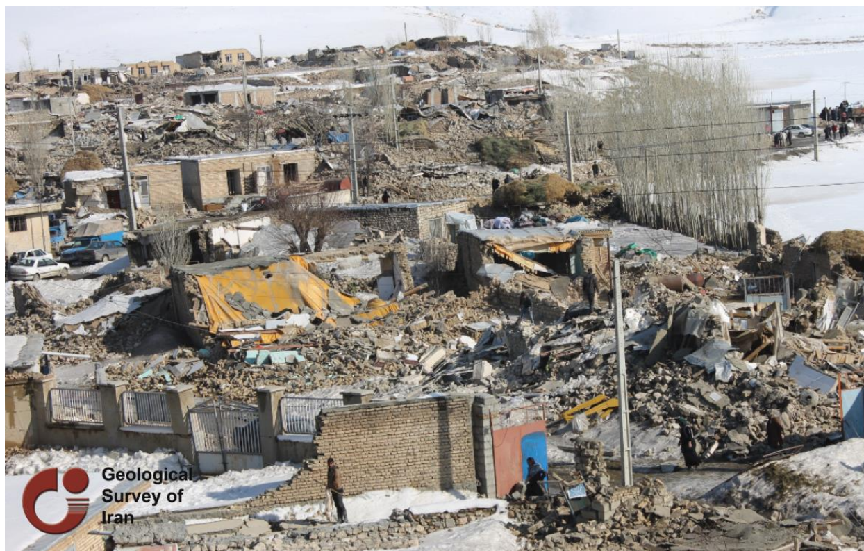
تخریب گسترده در بخش جنوبی روستای گیرناویک.
