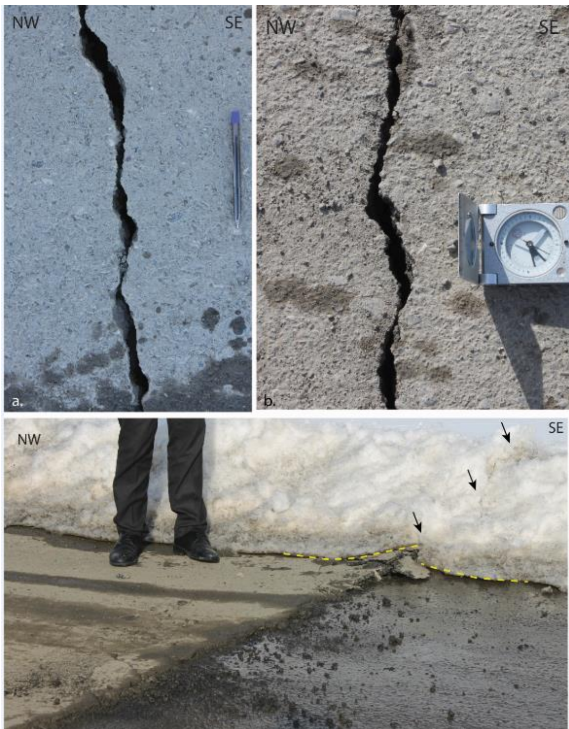
شکل ۷. گسیختگی های با جابجایی جزئی در عرض جاده گیرناویک-میرعومر و شانه خاکی آن. این گسیختگی ها به احتمال مربوط به شتاب افقی وارده بر جاده می باشد و در بسیاری از موارد، امتداد قابل توجهی در خارج از جاده ندارند.
