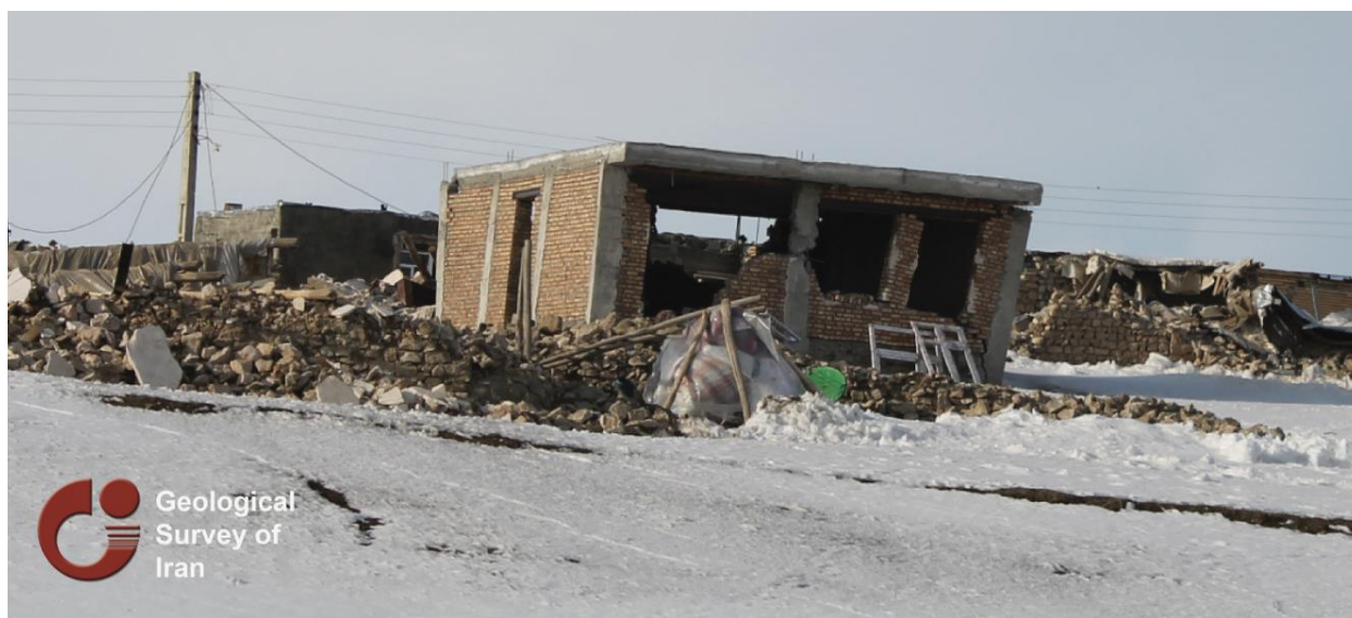
تخریب گسترده در بخش جنوبی روستای گیرناویک.
